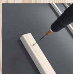
Isolatiemateriaal op dakspanten
