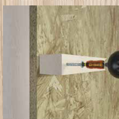
Bevestiging van regelwerk t.b.v. installaties
