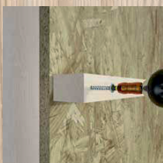
Bevestiging van regelwerk t.b.v. installaties
