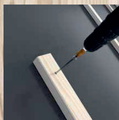
Isolatiemateriaal op dakspanten
